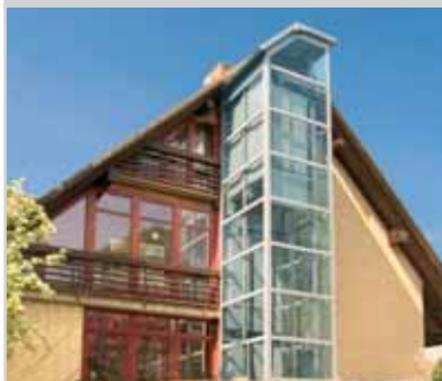
Eine andere Variante sind selbsttragende Schachtgerüste, die beispielsweise im Außenbereich montiert werden können und mit einer Aluminium- und Glaskonstruktion zum Element moderner Architektur werden.
