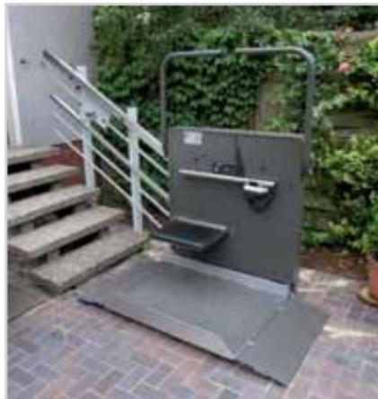
Mit Hilfe eines Plattformlifts können Rollstuhlfahrer Treppen und Eingangsstufen problemlos überwinden. Auch bei Plattformliften gibt es, wie hier zu sehen, Varianten, die mit einem klappbaren Sitz ausgestattet sind.
