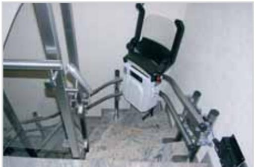
Die Treppe sollte durch den Einbau eines Treppenlifts möglichst nicht beschädigt werden. Die Wandmontage schont die Treppe, da sie nicht angebohrt werden muss.
